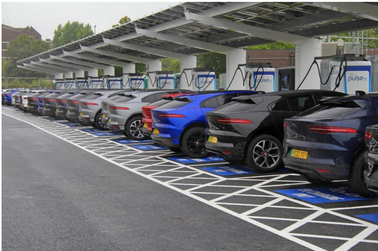
*Jaguar I-PACE soutient l'ouverture de l'une des plus grandes stations de recharge d'Europe. Une borne de recharge en courant continu de 100 kW permet d'augmenter l'autonomie de 127 km (WLTP) en seulement 15 minutes.*
